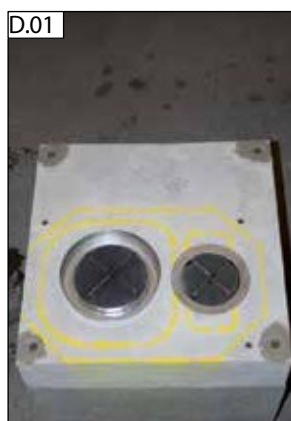
Pohled na skutečný stav před zahájením instalace.
