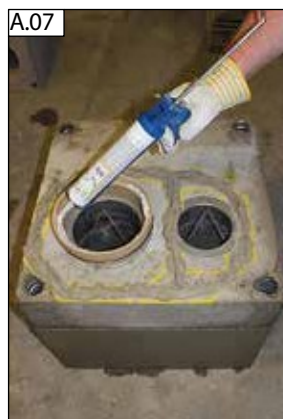
Na adaptér (12) naneste těsnicí hmotu RAPID (7).
