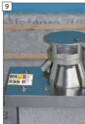
9 K zajištění krycí hlavy použijte podložky a utáhněte křídlové matice.
