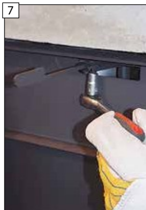
7 Pevně přišroubujte ovládací prvek.
