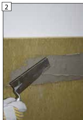
2 Speciální izolační sadu KINGFIRE pro boční stěny lze volitelně přilepit na vnitřní stěnu nebo příčku, případně...
