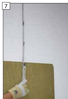
7 Odměříte rozdílový rozměr ke stropu na straně budovy.
