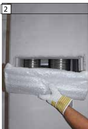
Vyjměte mřížku konvekčního vzduchu z montážního otvoru.
