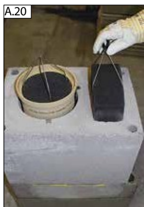
Zasuňte horní pro přívod vzduchu do šachty.
