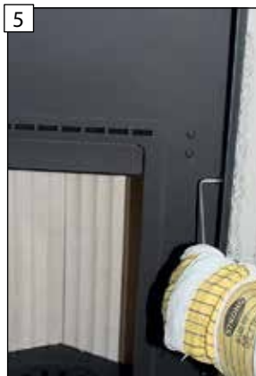
Po připevnění krycího rámu k obkladu, realizovanému na stavbě, utáhněte šrouby, aby byl pevně připevněn.
