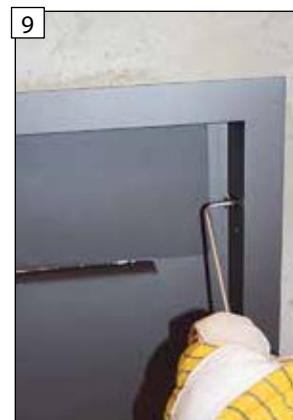
9 Krycí rám po přiložení na obklad realizovaný na stavbě dotažením šroubů pevně zafixujte.
