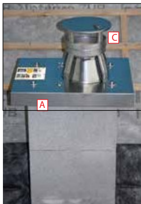
Pohled na zakončení krycí nerezové desky (A) s krycí hlavou "EAGLE" (C).
