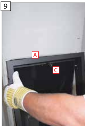
9 Krycí rám (A) osadte pod úhlem nad ovládací prvek přívodu vzduchu (C) a poté upravte zbývající strany rámu.
