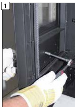
1 Odmontujte dodané ovládání dveří D.
