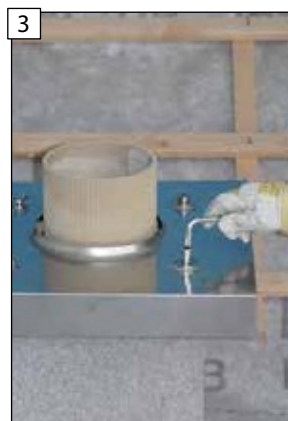
Inbusové šrouby pevně dotáhněte.
