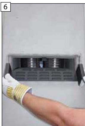
Nastavte pohledovou clonu do šikmé polohy a vsuňte ji do otvoru konvekčního vzduchu. Potom ji posuňte směrem dolů až k dorazu.
