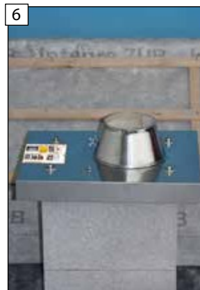
Pohled na prvek desky po montáži.
