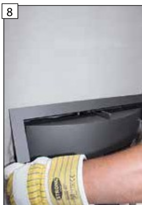
8 Krycí rám nejprve pod sklonem přiložte za ovládání přívodu vzduchu a nastavte ho na požadovanou míru.
