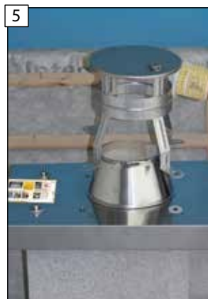
5 Umístěte silikonová těsnění na desku a poté umístěte krycí stříšku na krycí desku tak, abyste ji mohli uchytit pomocí šroubů.
