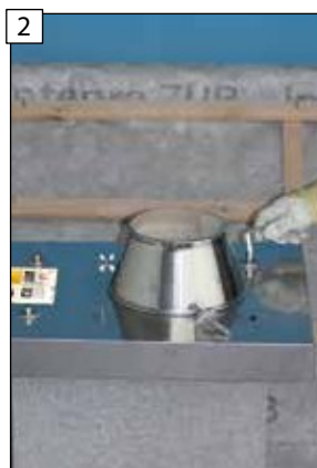
Vyšroubujte upevňovací šrouby krycí desky.
