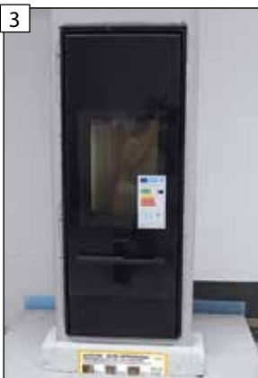
Pohled na stav před montáží. POZOR! Zkontrolujte dilataci kolem celého spotřebiče.
