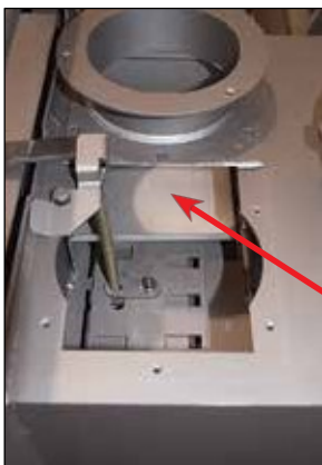
Pohled na prostor pro přívod po demontáži horní části topné komory. Krycí deska zabraňuje propadávání nečistot během instalace a zablokování ovládání přívodu vzduchu. Chrání také před přepadem nečistot při čištění průduchu.
