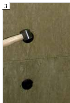
3 ... upevnit pomocí klínů vhodných pro izolační materiál.
