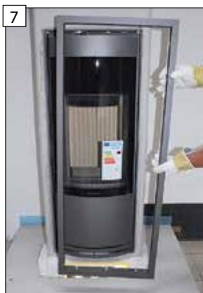
7 Nastavte montážní rám. POZOR! Podle polohy upevňovacích šroubů vytvořte správnou polohu pro montáž!
