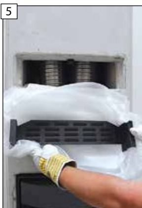
Vybalte pohledovou clonu. DŮLEŽITÉ UPOZORNĚNÍ! Dávejte pozor, abyste nepoškodili povrch pohledové clony nebo lakované plochy!
