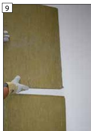
9 Horní desku s perem a drážkou zasuňte do desky s dvojitým perem.
