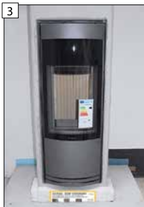
3 Pohled na stav před montáží. POZOR! Zkontrolujte dilataci kolem celého spotřebiče.
