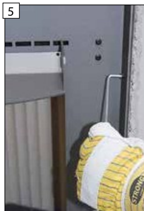
5 Pomocí inbusového klíče zcela vyšroubujte všechny upevňovací šrouby na rámu topeniště.
