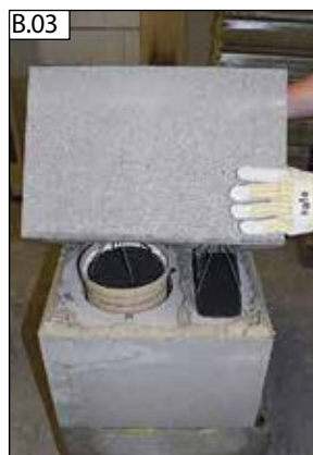
Osadte tvárnici Schiedel ABSOLUT.
