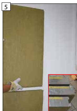
5 Do desky s drážkou osadíte desku s dvojitým perem a potom..
