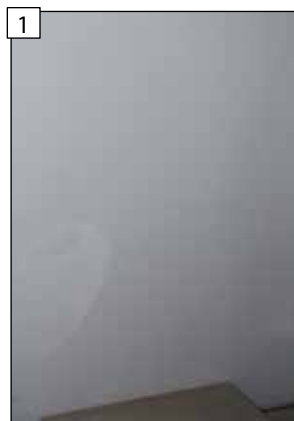
1 Pohled na stav před zahájením instalace.
