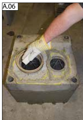
Vyčistěte hrdlo adaptéru (12) houbičkou.
