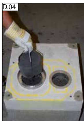
Vložte spodní díl pro odvod spalin (1).
