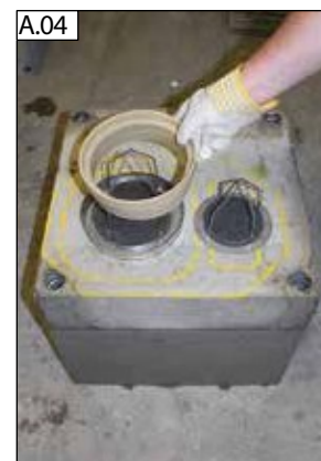
Zasuňte adaptér (12) do průduchu.
