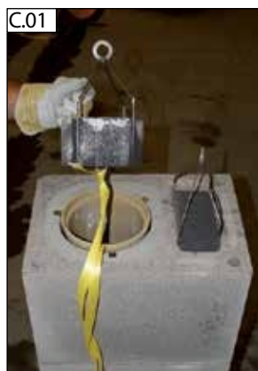
Vytáhněte horní díl (3) odvodu spalin z průřechu.
