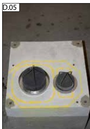
Vložte spodní díl pro přívod vzduchu (2).
